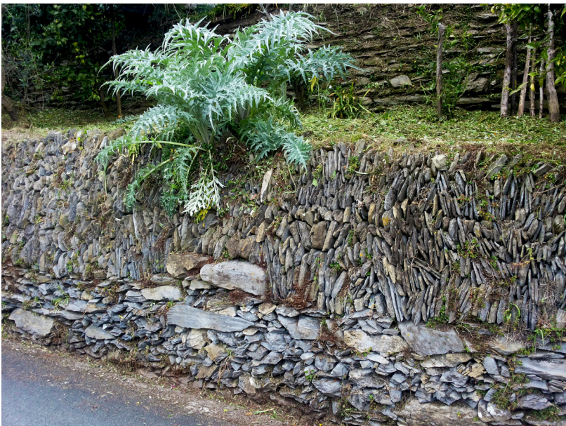
Particolare disposizione delle pietre del muro a secco nei pressi di Canevale (comune di Coreglia Ligure GE)
